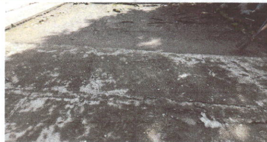
Foto 6: Sustitución de piso de torta de concreto
