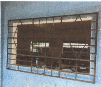
Foto 5: Mantenimiento a balcones de metal
