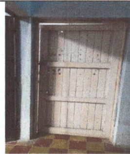
Foto 4: Sustitución de puerta
